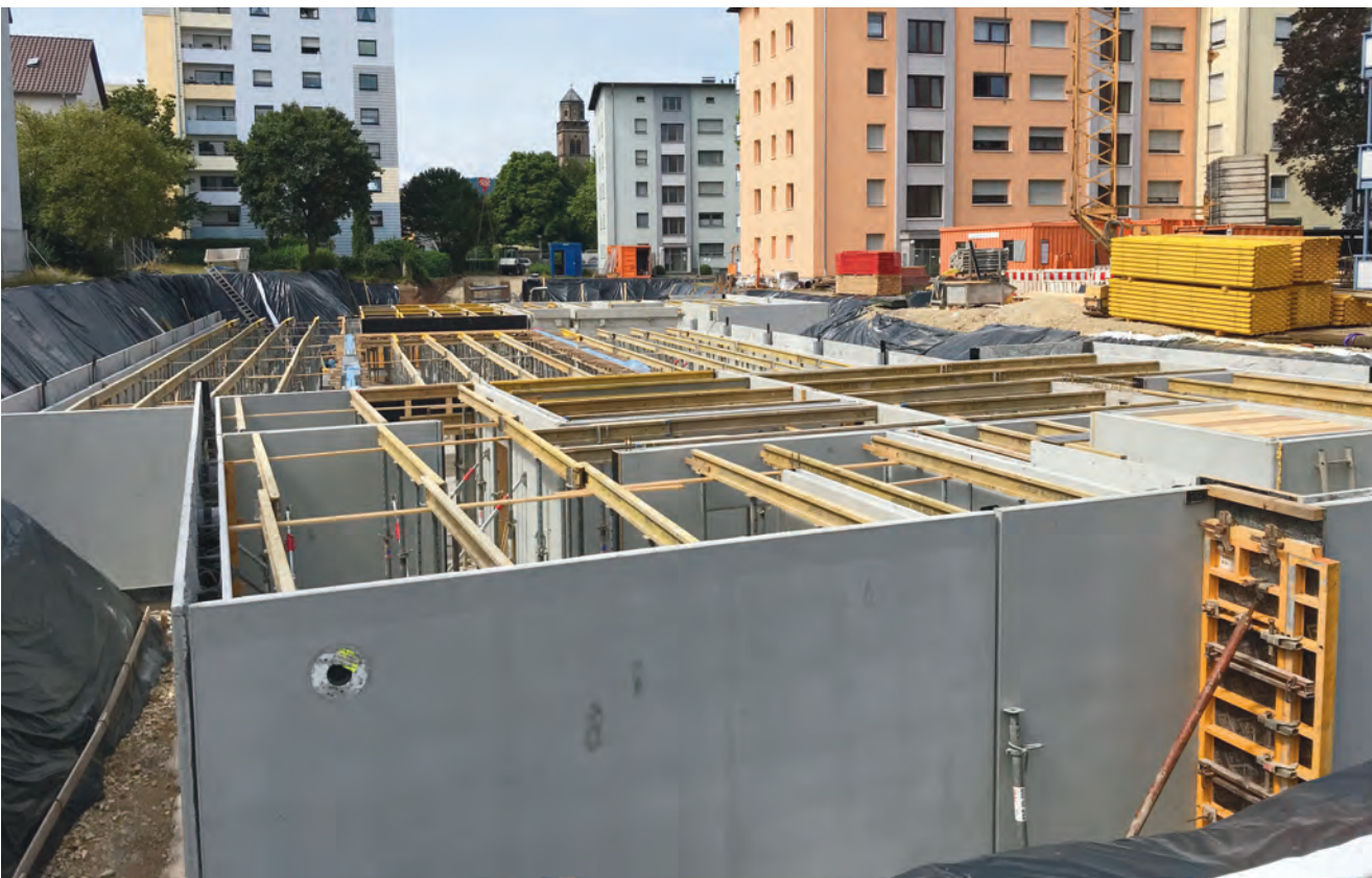
Verdichtungsmaßnahme im Maarviertel – Erd- und Betonarbeiten
